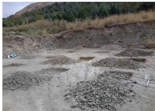
شکل ۴- تسطیح و آماده‌سازی سایت مطالعاتی و آماده کردن محل اجرای میخ‌ها
