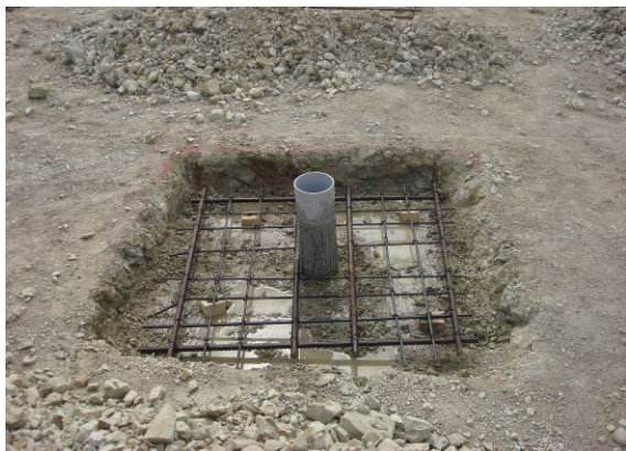
شکل ۵- نحوه اجرای فونداسیون بتنی مسلح در محل اجرای میخ‌ها جهت استقرار دستگاه کشش و اعمال بار کششی
