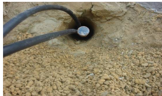
شکل ۷- حفاری، میلگردگذاری و نصب لوله‌های تزریق گروت
