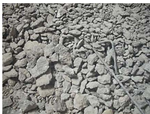
شکل ۲- بتن‌های تخریبی که به دلیل تخریب با چکش برقی دارای اندازه‌های مختلف بودند
