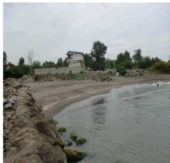
شکل ۲۲- تغییر شکل ساحل در حضور آبشکن غیر مستغرق در منطقه دهنه سر سفیدرود (تابستان ۱۳۹۱)
