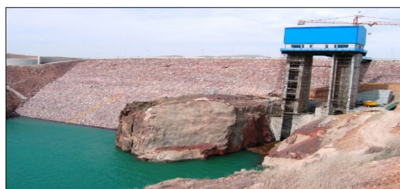
شکل 1- نمای بصری سد خاکی آیدوغموش: (الف) نمای کلی، (ب) جزئیات آبگیر
