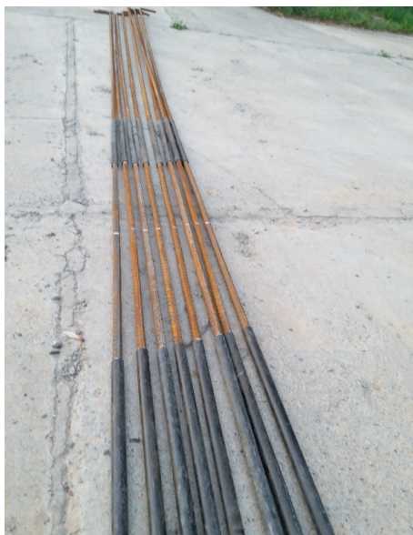
شکل 1- قرار دادن غلاف پلاستیکی در آرماتورهای طولی قبل از شروع مراحل آرماتوربندی
