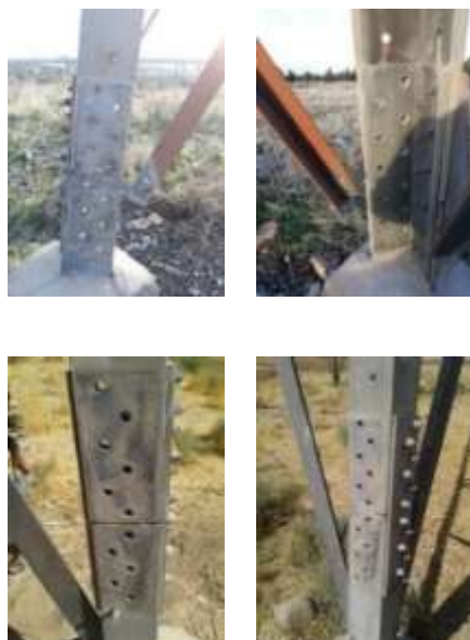
شکل 1- سرقت پیچ‌های اعضای متصل به هم در قسمت پایه‌ی دکل‌های انتقال نیرو
