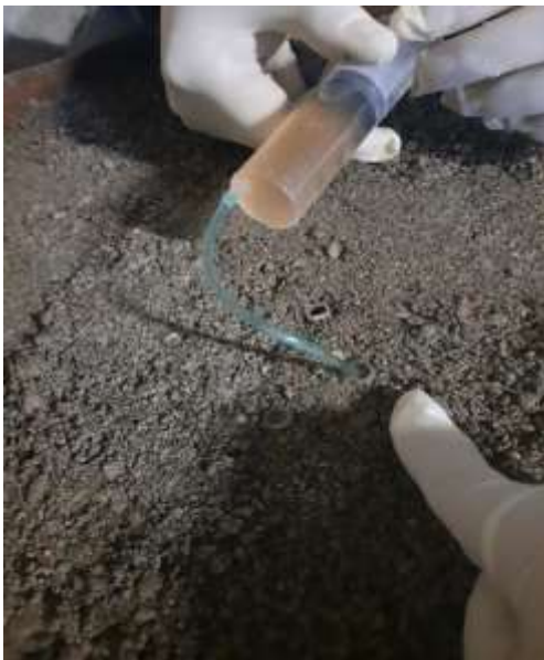
شکل ۱۰- مراحل تزریق ریزشمع زیستی
