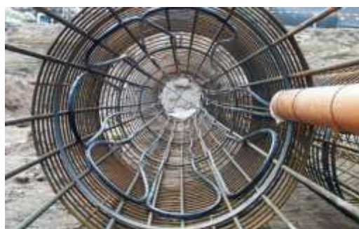
شکل ۱- میلگردهای شمع انرژی و لوله‌های جاذب (Brandl, ۲۰۰۶)
