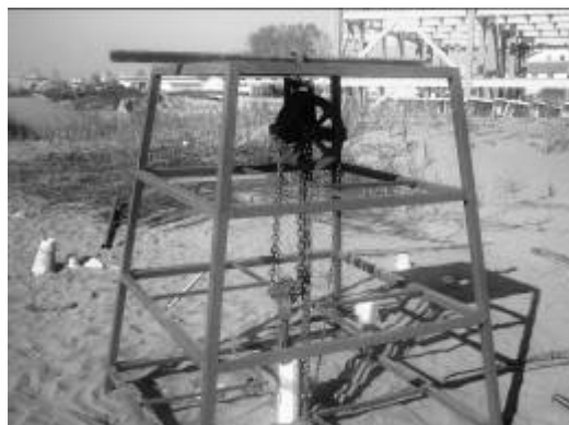
شکل ۵- تجهیزات خارج کردن غلاف از داخل خاک
