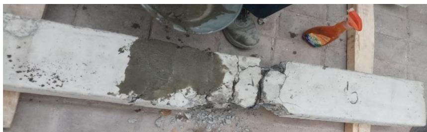
شکل ۴- مقاوم سازی نمونه کنترل آسیب دیده
