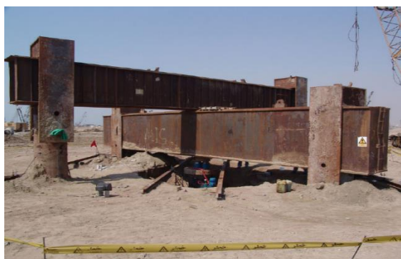
شکل ۶- تیر اصلی و شمع‌های تکیه‌گاهی آزمایش بارگذاری شمع در پروژه بندر شهید رجایی
