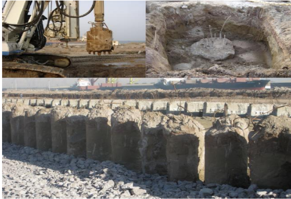
شکل ۳- شمع‌های درجاریز بتن مسلح
