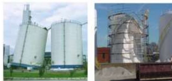
شکل ۳- الف) بلندشدگی یا Uplift، ب) برخورد اشیاء
