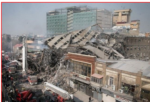
شکل ۱- خرابی پیش‌رونده در ساختمان پلاسکو تهران
