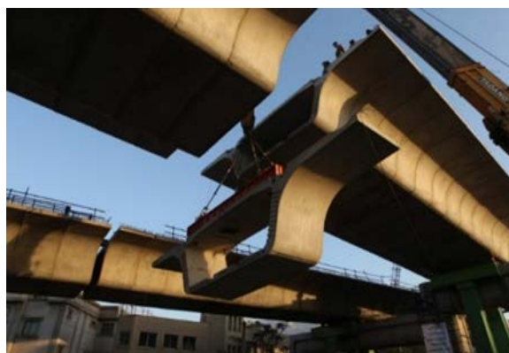
شکل ۴- قطعات بتنی پیش ساخته با بتن خود متراکم
