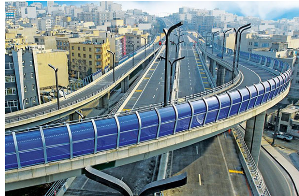
شکل ۵- دیواره صوتی به کار رفته در بزرگراه طبقاتی صدر
