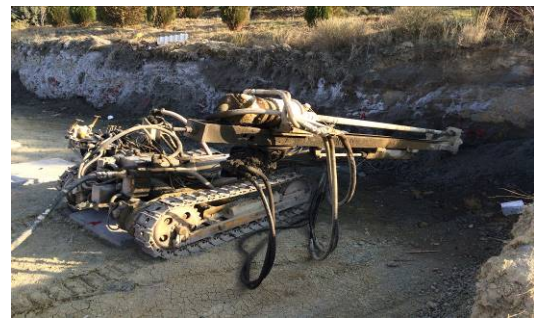
شکل ۶- دستگاه حفاری مورد استفاده در پروژه
