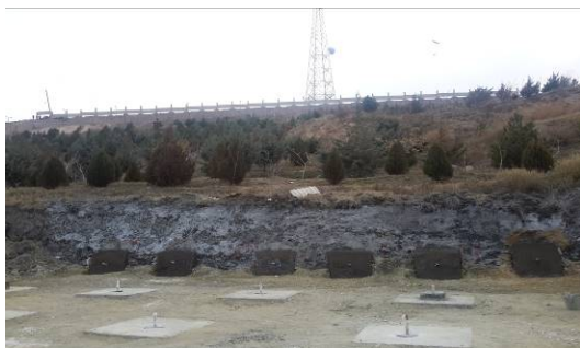
شکل ۱۱- میخ‌های اجرا شده در دیواره گودبرداری با دال بتنی مسلح در انتهای آن جهت نصب تجهیزات انجام آزمون
