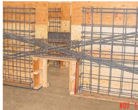
شکل ۴- تصویری از تیر مزدوج بتنی با آرماتور قطری (DBCB) [۲]
